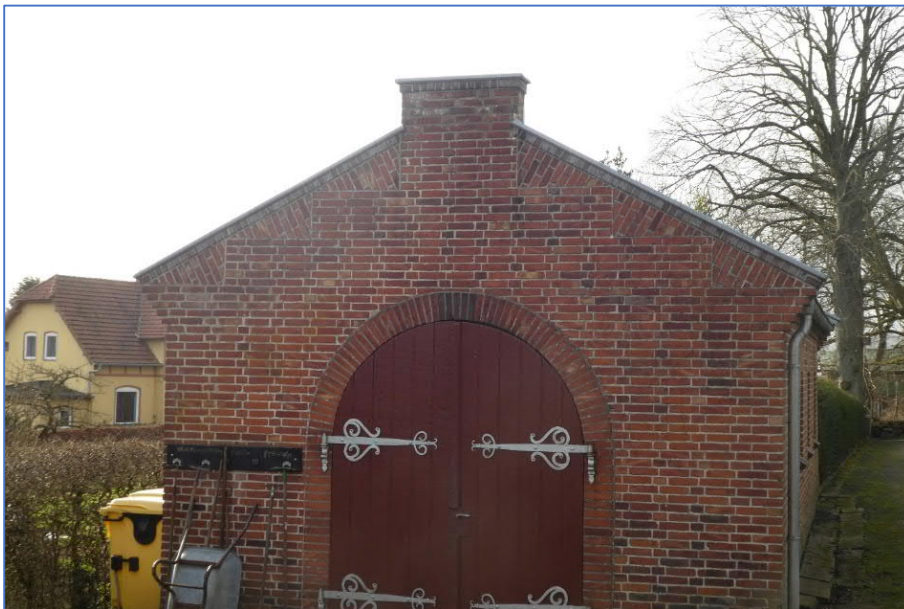
Backsteinschuppen Süderbrarup (N2)
