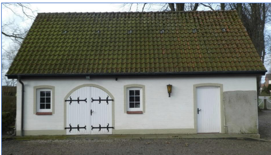
Mehrzweckge- bäude Ulsnis (N3)
