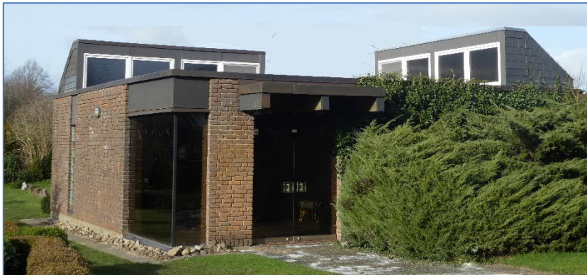
Mehrzweckgebäude Böel (N6)
