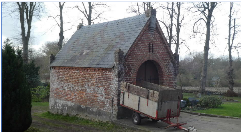
Friedhofsgebäude Norderbrarup (N7)
